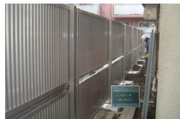
警視庁高輪署独身寮フェンス
