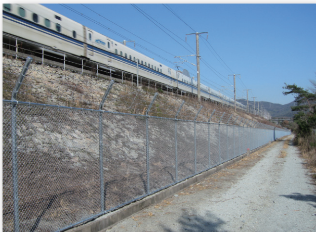
JR フェンス工事
