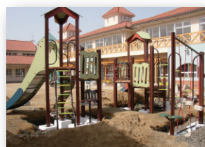
某幼稚園遊具基礎 (和歌山県)
