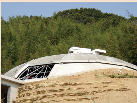
発泡スチロールドーム設置状況5
