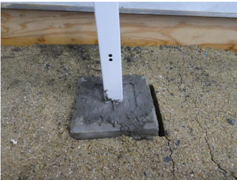
写真-6 試験体の状況（最大荷重時）
