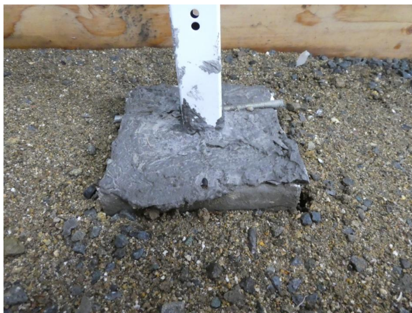
写真-4 試験体の状況 (除荷時)
